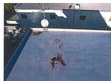
定期的な点検空撮で発見
