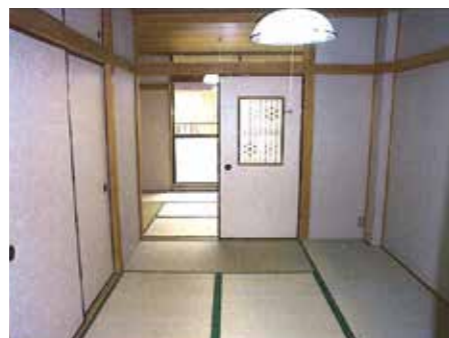
構造材の柱が見えている和室が2室
