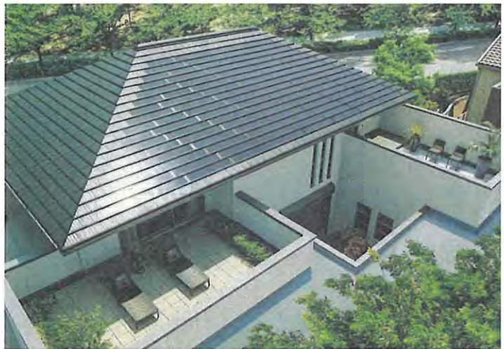
(瓦型太陽光発電システムを配した「グリーンファーストゼロ」)
