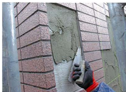
下地材で不陸調整をしっかり行った上で
