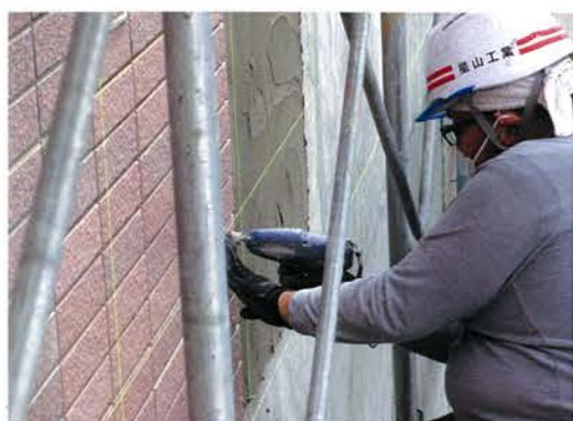
強力な専用ボンドでタイルを貼り込む
