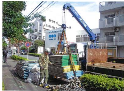
まずは足場部材を搬入します
