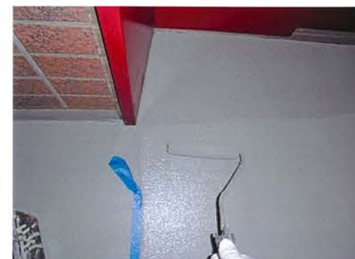
防塵防水塗装の2度塗りです
