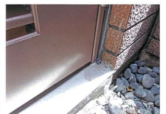
フレームを含め新品交換となりました
