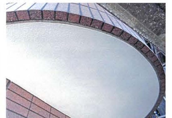
インクラバーコートで仕上塗装
