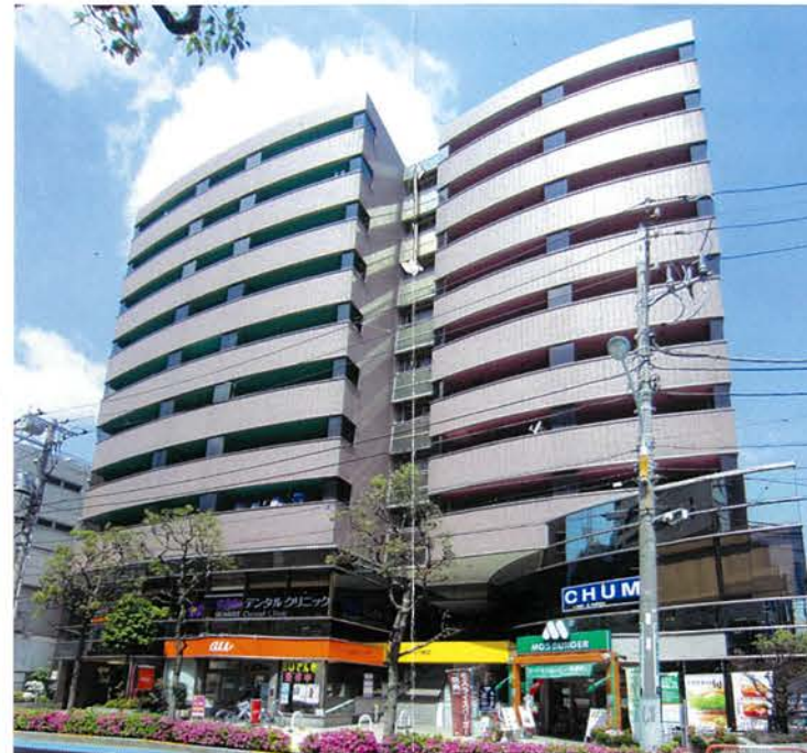
下記写真の様に外壁タイルの一部に剥落した部分が
