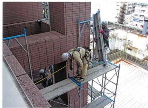
建物を囲む様に足場を組立てます
