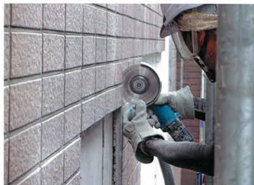
タイルカッターで切断して中の状況を
