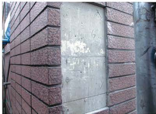
その危険な部分をしっかりと撤去する
