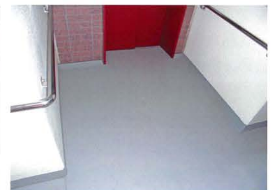
共用通路の床も新築同様です
