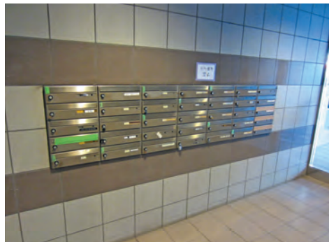
風除室に設けられたメールボックス
