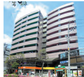
SRC構造10階建の外観
