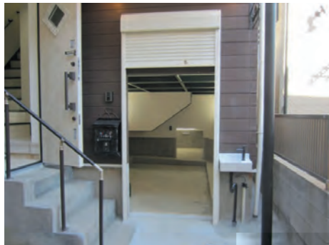
いろいろと便利な外水道シンクが 完備して使い方はいろいろ
