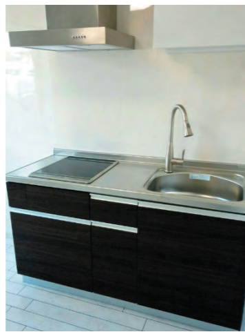
オール電化システムによる 2口IHクッキングヒータキッチン
